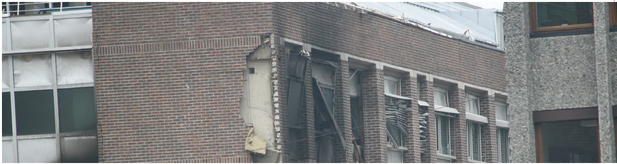
Maltrakterte bygninger i regjeringkvartalet etter terroren 22. juli
